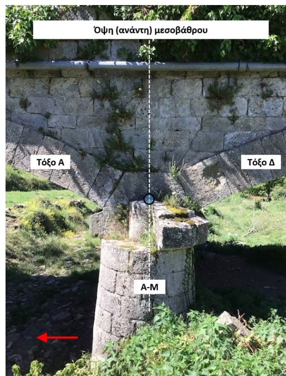
Εικόνα 62 : Όψη (ανάντη) στροφικής μετακίνησης μεσοβάθρου.
