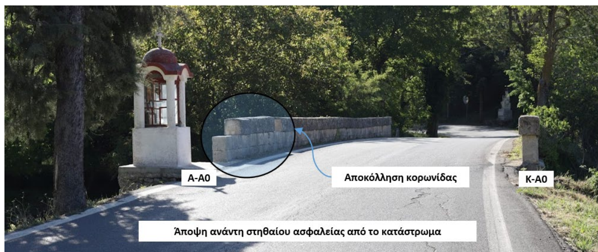
Εικόνα 43 : Αποκολλήσεις λίθων του (ανάντη) στηθαίου ασφαλείας.
